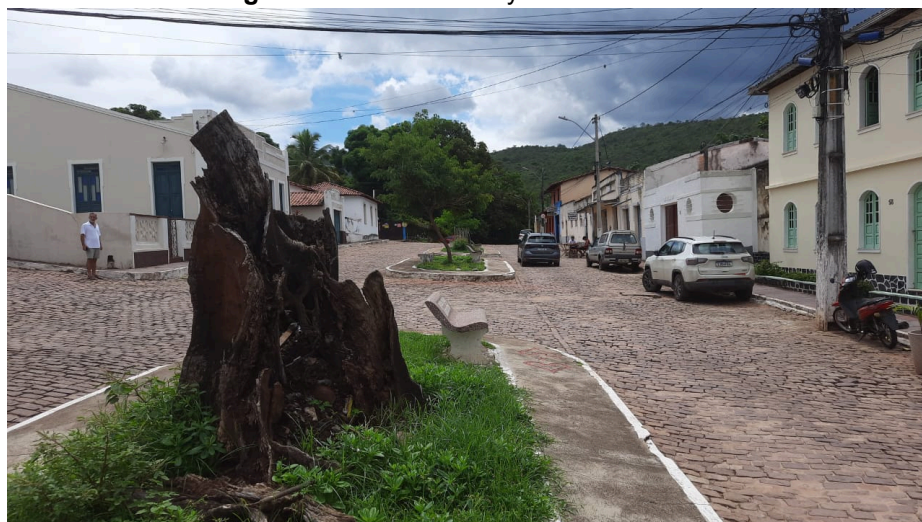
Figura 21 - Avenida Ruy Barbosa vista 1.
