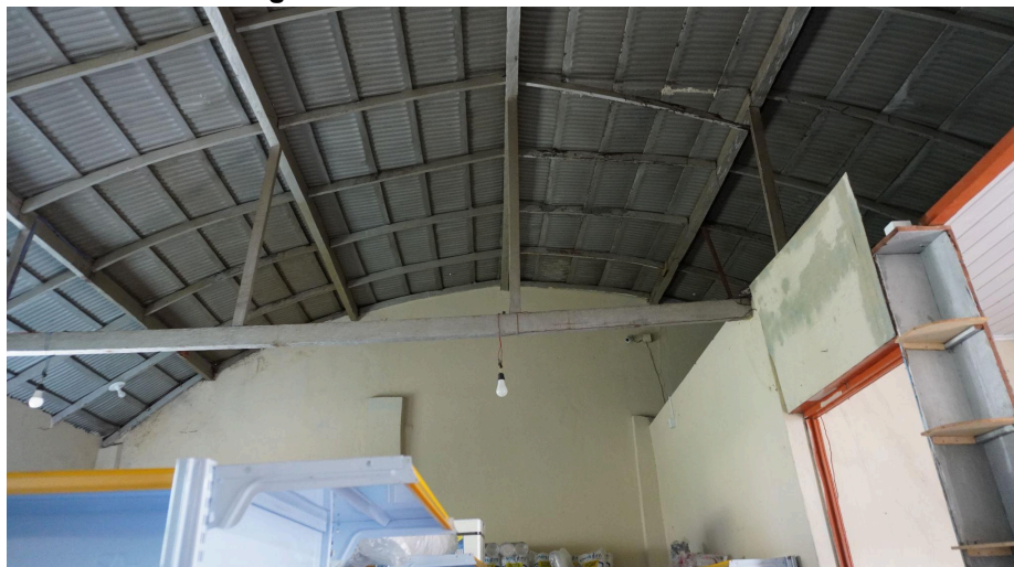
Figura 34 – Telhado na área do mercado.
