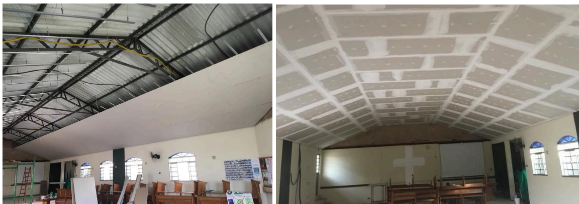
Figura 60 - Exemplo de forro de gesso acartonado suspenso em estrutura metálica.
