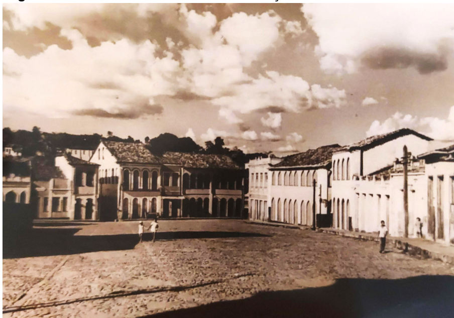
Figura 02 - Vista externa dos Imóveis da Praça Horácio de Matos em 1972.
