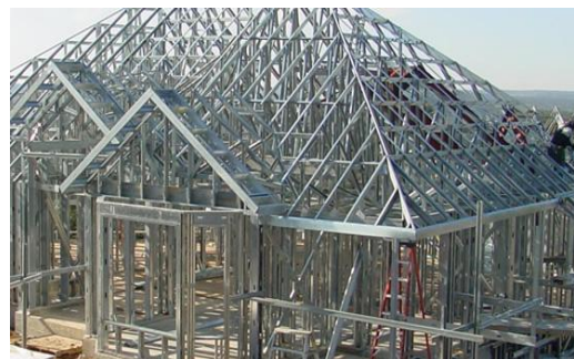
Figura 6 e 7: cobertura steel frame
