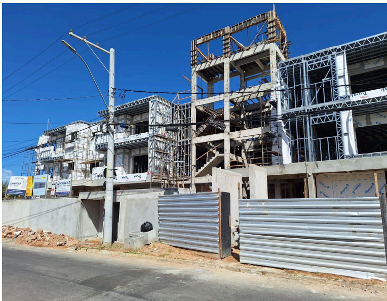
Figura 4: fachada da obra
