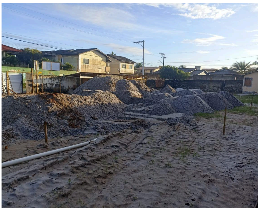
Figura 8: Terreno da obra
