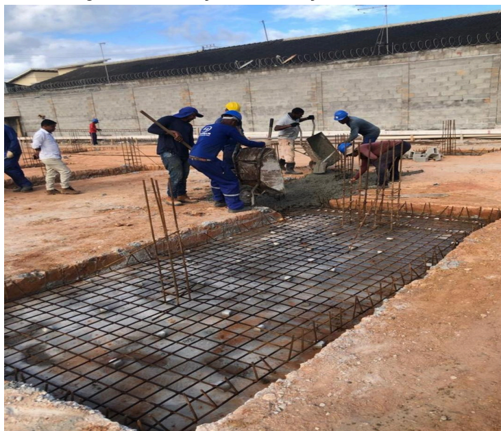
Figura 9: Execução da fundação radier na obra.
