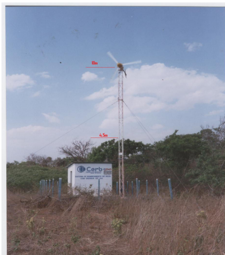
Figura 10 – Estação de bombeamento de São Gabriel Fonte: Carlos Bruni
