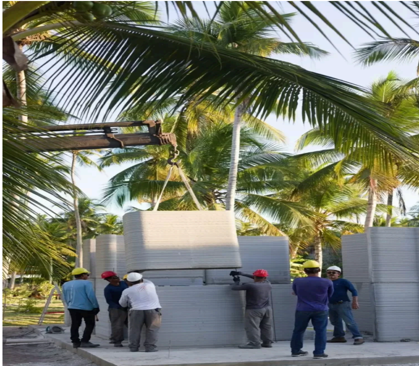
Figura: 19 - Montagem da casa impressa na Bahia
