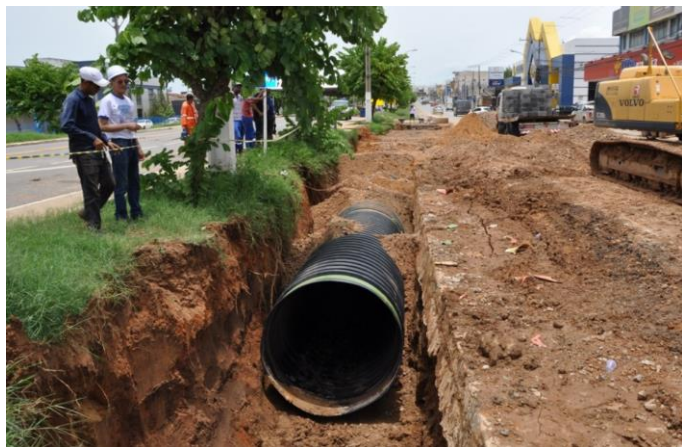
Figura 60 – Obras no sistema de drenagem da av. ACM - https://barreiras.ba.gov.br/prefeitura-de-barreiras-executa-obras-na-av-acm-para-conter-erosao-e-ampliar-sistema-de-drenagem/
