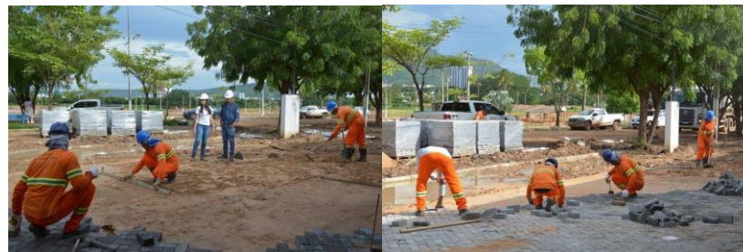
Figura 31 - Obras em andamento no Parque Natural de Barreiras - Fonte: Disponível em: < https://barreiras.ba.gov.br/obras-de-construcao-e-implantacao-do-parque-natural-engeraldo-rocha-seguem-em-ritmo-acelerado-em-barreiras/ > Acessado em 20 de janeiro de 2023
