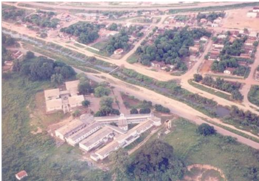
Figura 24 - Canal do Rego antes de 1995 - Fonte: Memorial descritivo - Usina da memória (e) de todas as coisas
