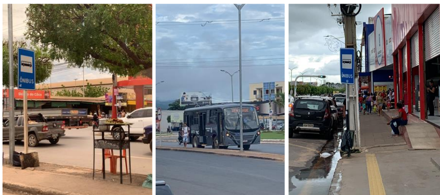
Figura 87 - Parada de ônibus BR-242 e Avenidas Laterais - Fonte: o autor 2022
