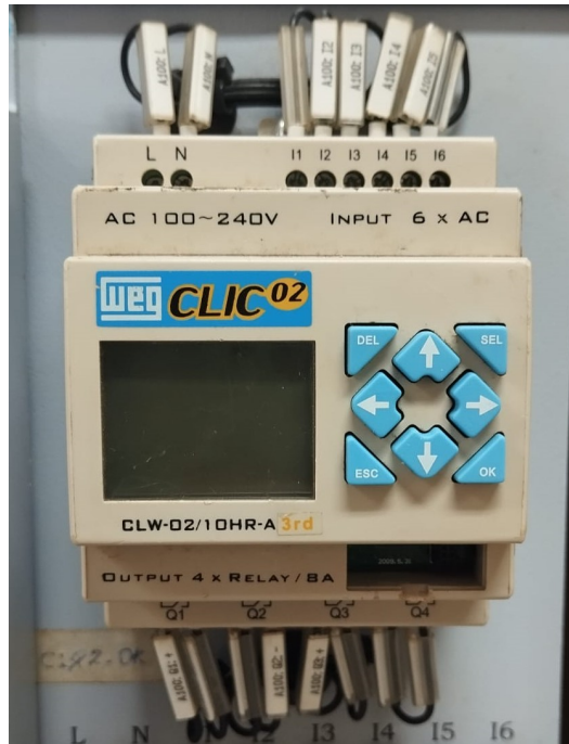
Figura 25 – Controlador lógico programável disponível na instituição.
