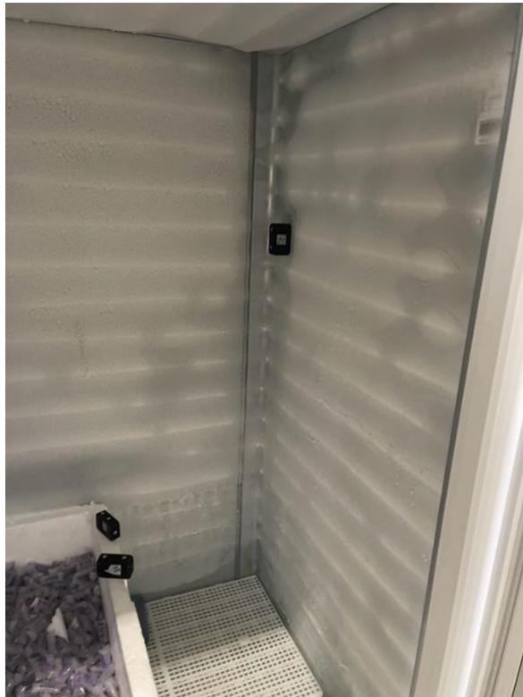
*Figura 66 - Sensores instalados na câmara refrigerada (Fonte: o autor)*
