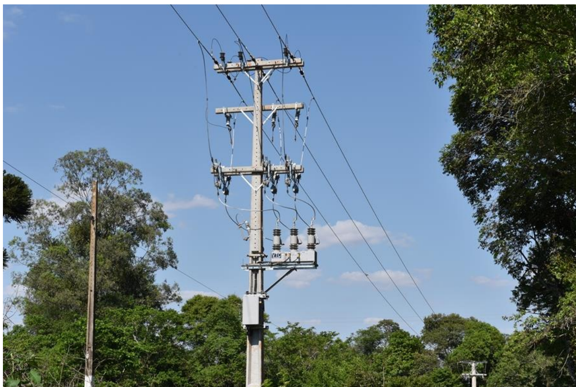
Figura 2.10 - Religador automático na rede
