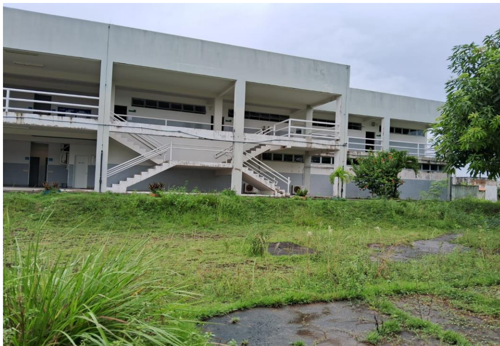
Figura 23- Pavilhão anexo de aulas
