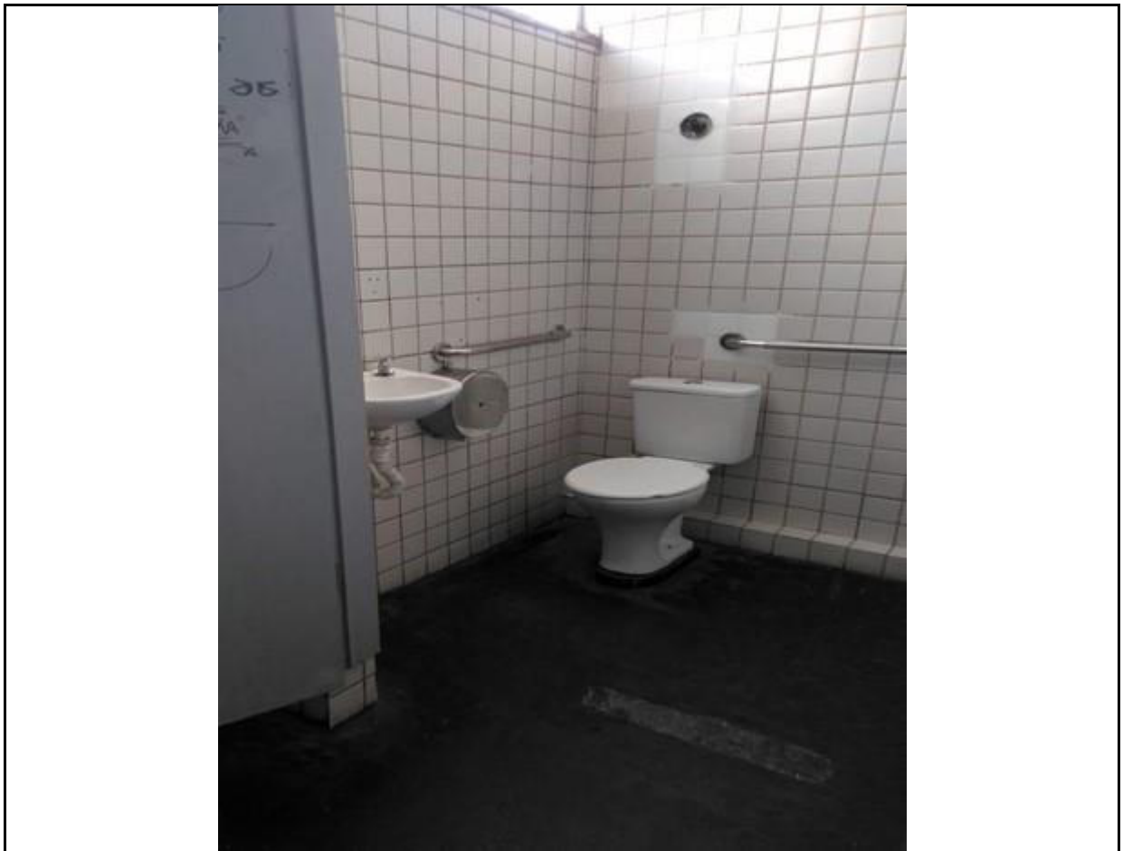
Figura 22 - Sanitário 1º andar
