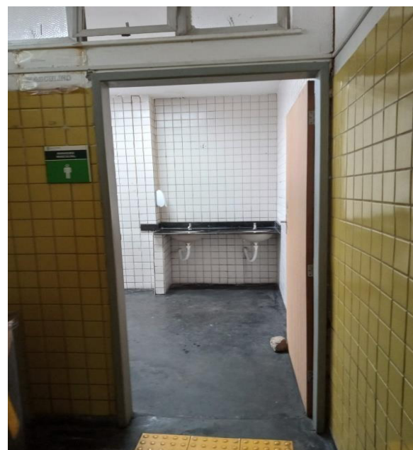
Figura 14- entrada do banheiro
