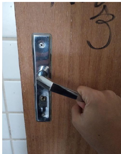
Figura 13 - maçaneta entrada do banheiro
