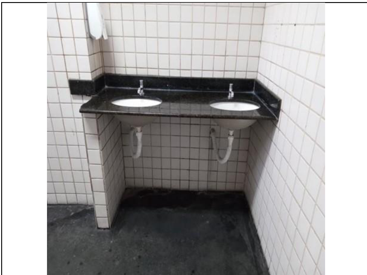
Figura 15 - lavatório 1º andar
