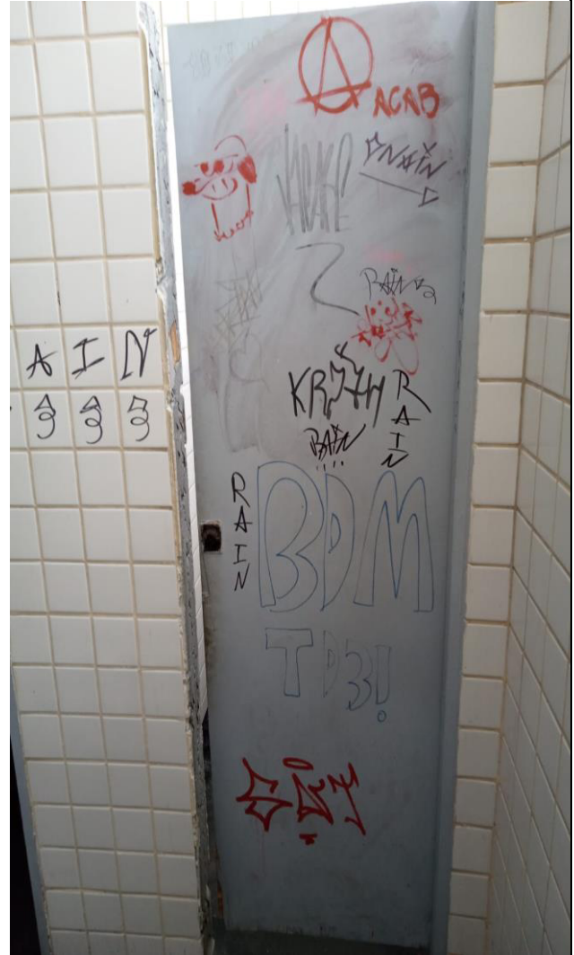
Figura 20 - porta sanitário 2º andar
