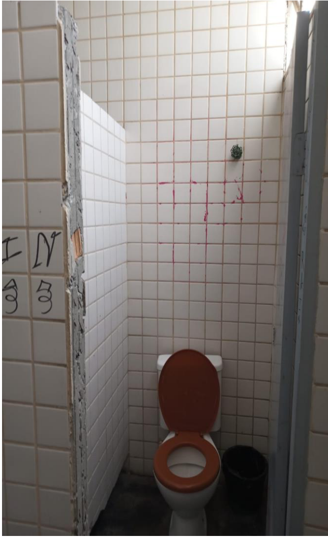
Figura 19 - sanitário 2º andar
