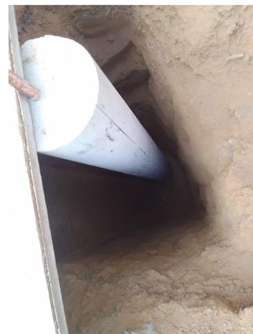
**Figura 3.9** – Instalação da haste concretada dentro do buraco.
