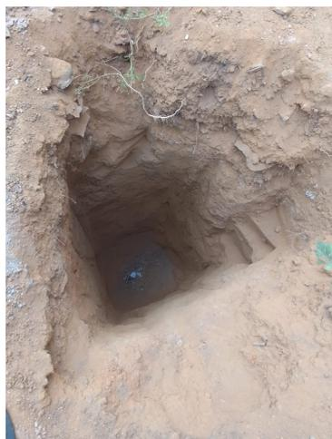
**Figura 3.8** – Buraco cavado no solo para instalação da haste.
