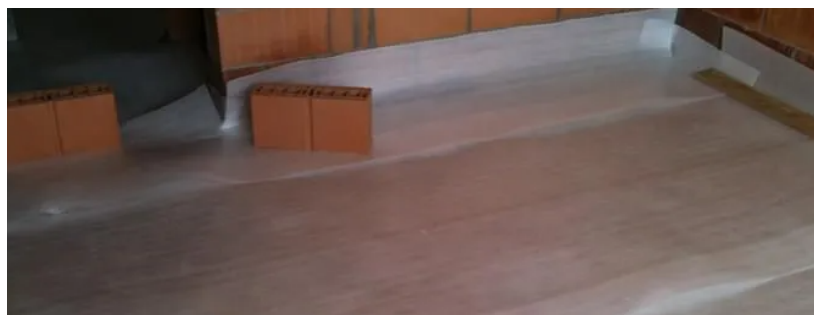
Figura 11 - Utilização de manta de polipropileno durante obra
