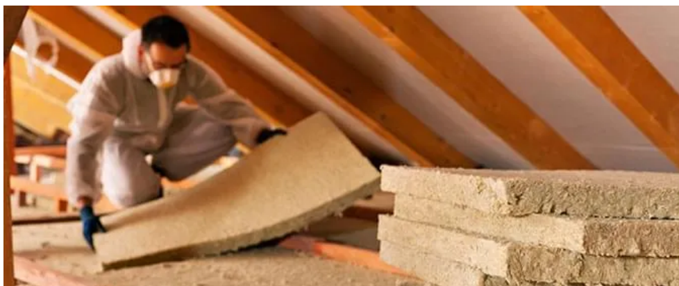
Figura 5 – Aplicação da manta de lã de vidro
