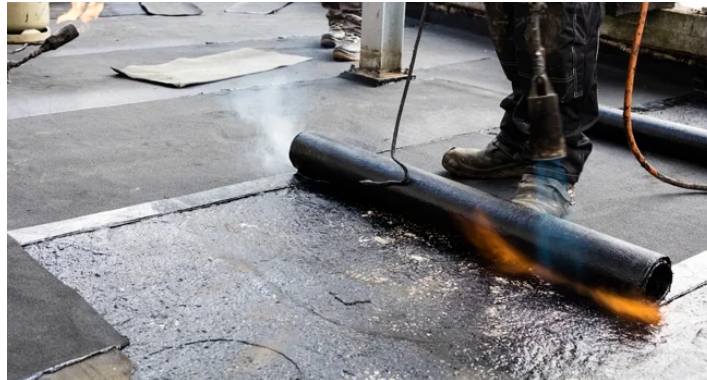
Figura 16 - Aplicação da manta asfáltica
