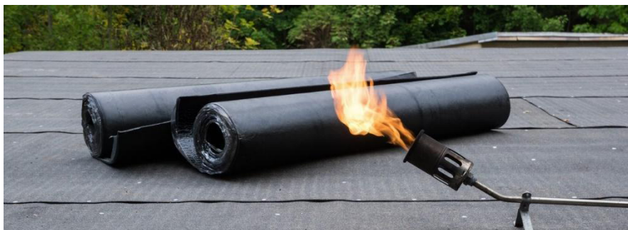
Figura 15 - Fotografia da manta asfáltica
