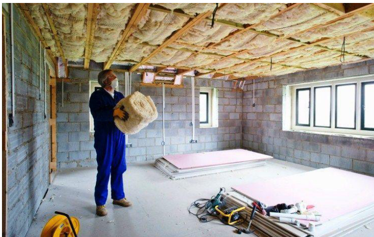
Figura 10 - Imagem da aplicação da manta de lã rocha
