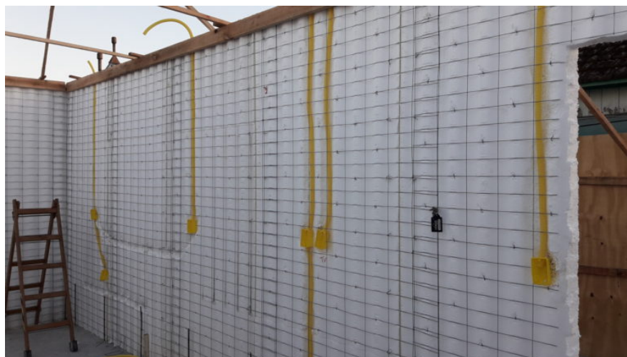
Figura 2: Instalação dos eletrodutos em EPS
