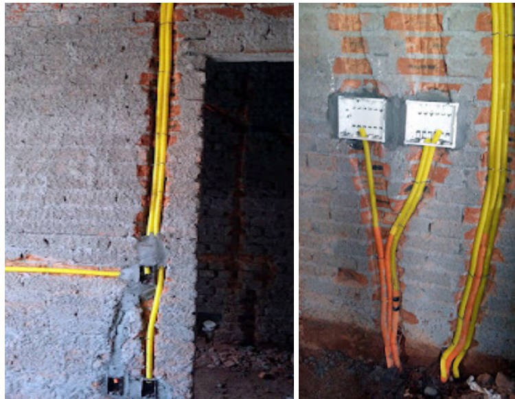
Figura 1: Instalação dos eletrodutos em alvenaria convencional
