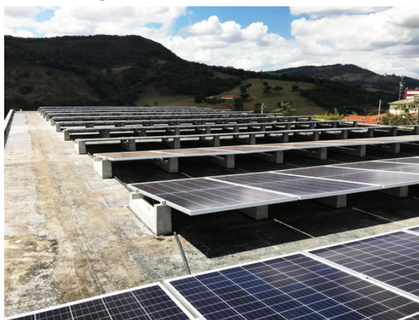
Imagem 2 – Estrutura em concreto
