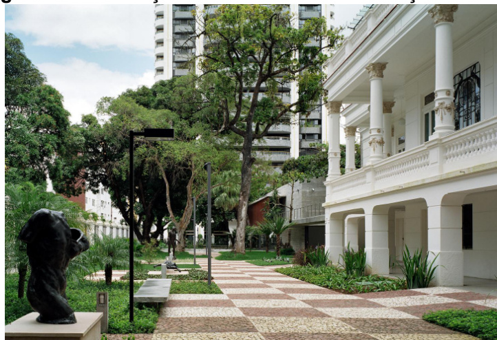
Figura 08 - Edificação existente e nova construção ao fundo
