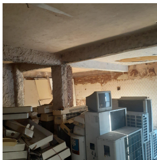
Figura 22 - Área interna garagem
