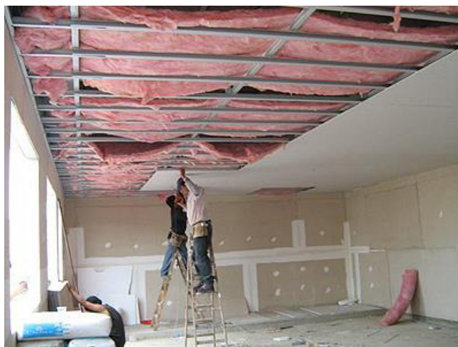
Figura 41 - Instalação de placas de gesso acartonado
