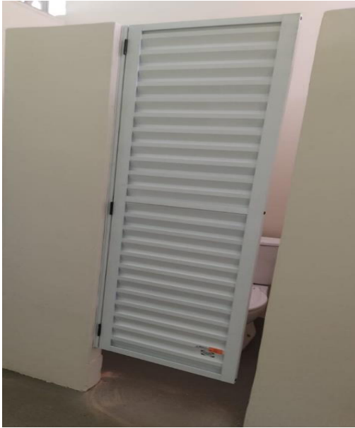
Figura 21 - Porta da cabine do banheiro
