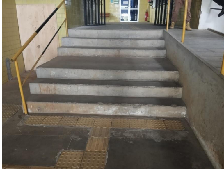
Figura 27 - Escada 02 ao lado da rampa
