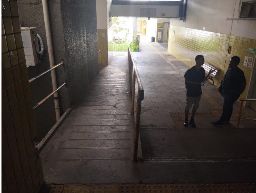
Figura 25 - Rampa de acesso 01
