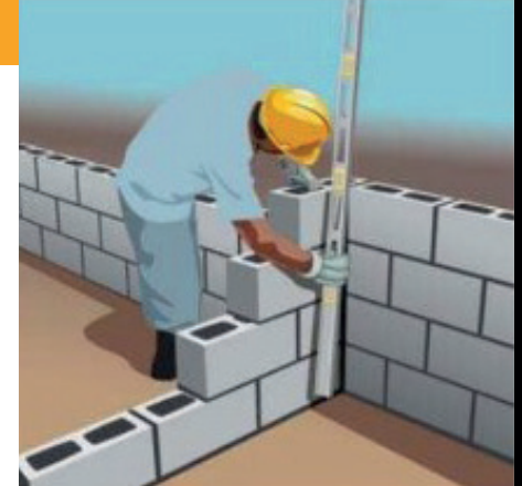
Figura IX - Assentamento de blocos
