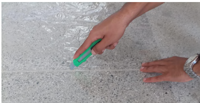
FIGURA 56- Corte da cobertura
