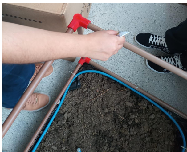
FIGURA 57- Colagem da cobertura
