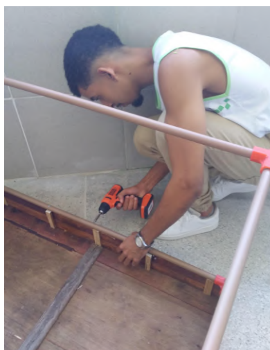
FIGURA 47- Furo da passagem de sensores
