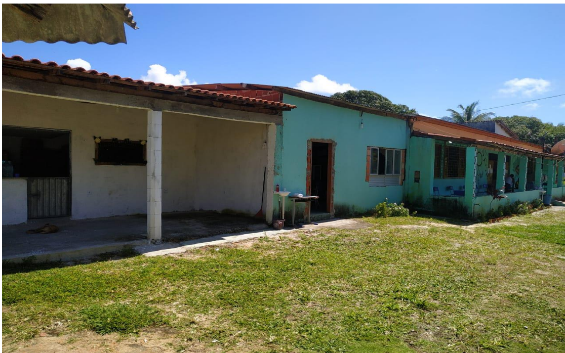
Figura 14 – Vista exterior da da EEITAB. Na construção branca a cozinha, ao seu lado a sala que já pertencia a escola Indígena e ao lado, cercadas por uma varanda, as salas que foram cedidas à Escola. Fonte: M. B. Oliveira. Setembro de 2020.
